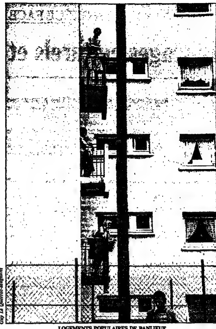
LOGEMENTS POPULAIRES DE BANLIEUE. La seule solution de rechange est-elle le paysage pavillonnaire ?
